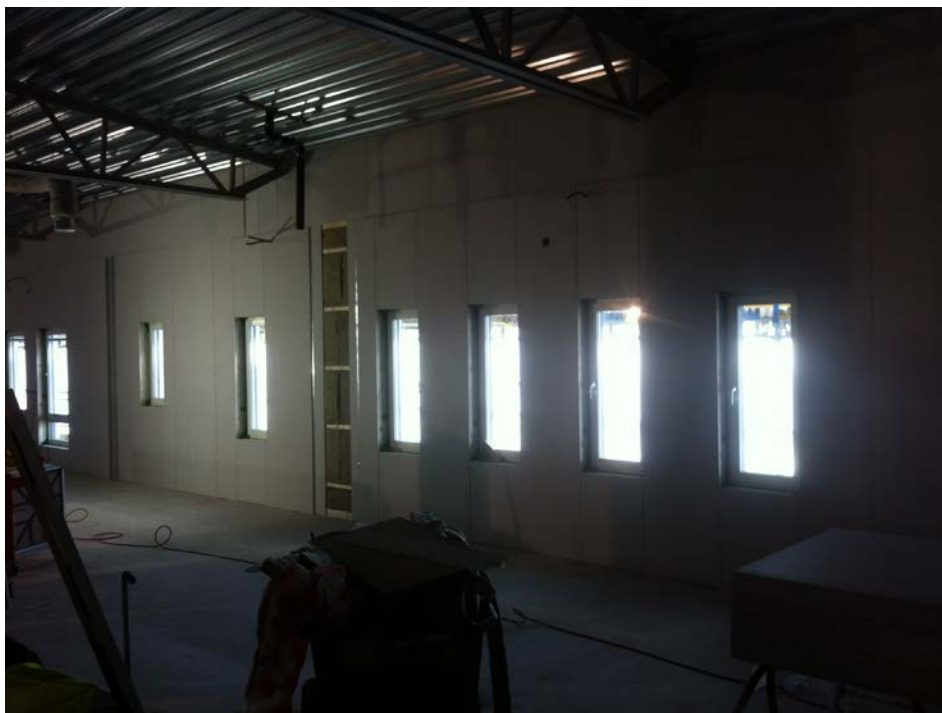
Figur 2 Färdigställd gipsvägg
