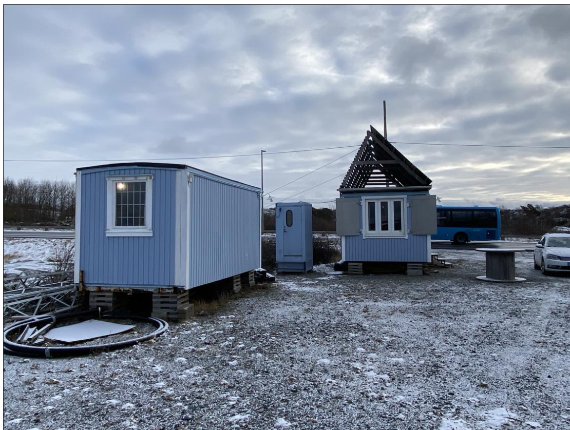
Figur 2: Byggnaderna på anläggningen. Till vänster är fikabyggnaden. I byggnaden till höger finns energimätare, kraftelektronik och annan liknande utrustning.
