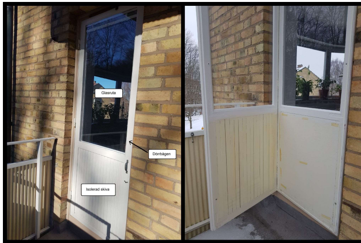
Figur 5: Illustration av dörrbladets komponenter (Foto av Alexander Sehlström).
