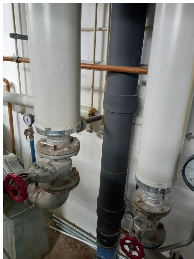
Figur 22. En MM-växlare som sitter placerad på Kustgatan 3.
