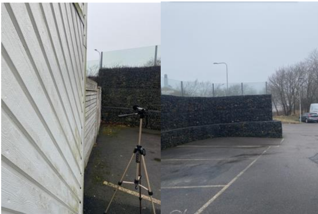
Figur A22: Exponerad fasad mot Kongahällavägen, utrustad med bullerskärm, M1.
