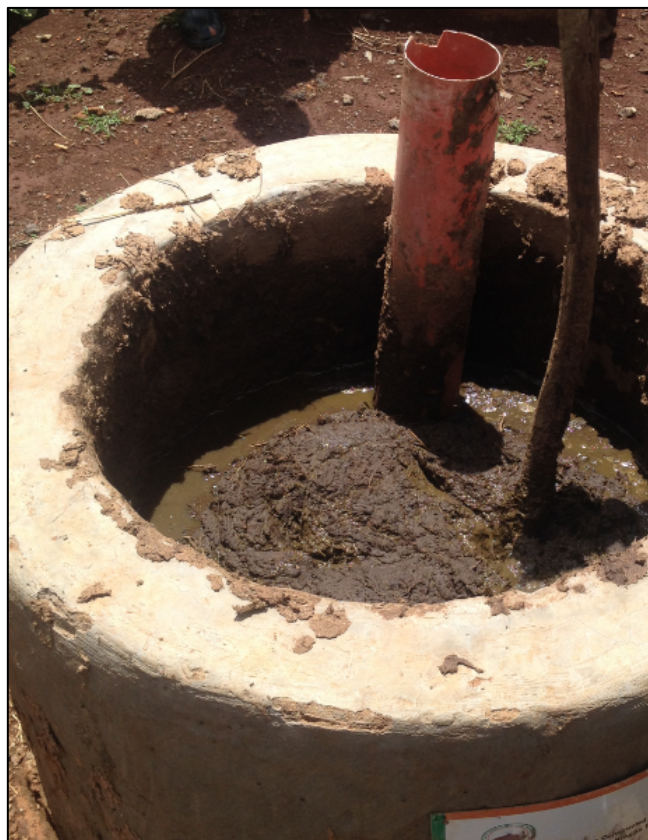
Figur 8. Slurry i inloppet till en biogasanläggning. Nairobi, Kenya.
