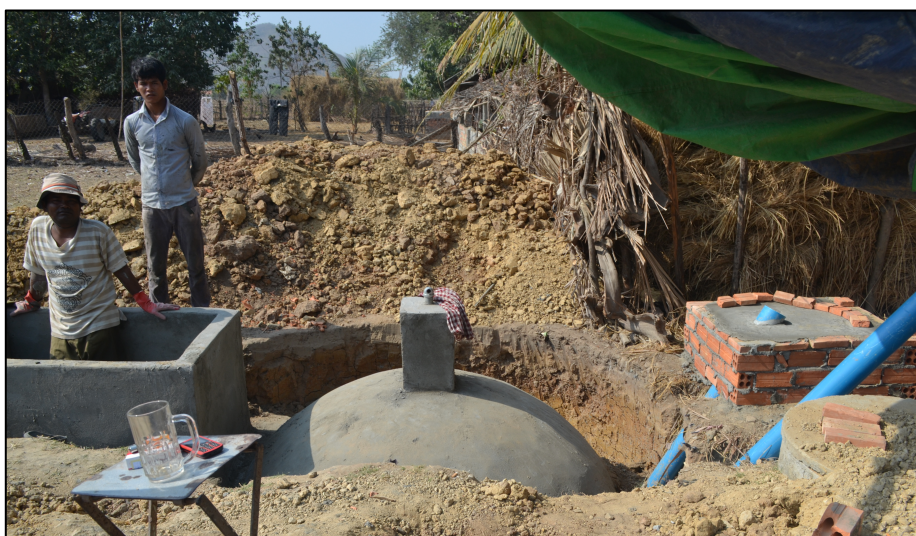
Figur 3. Biogasanläggning under konstruktion, Kampong Speu, Kambodja.
