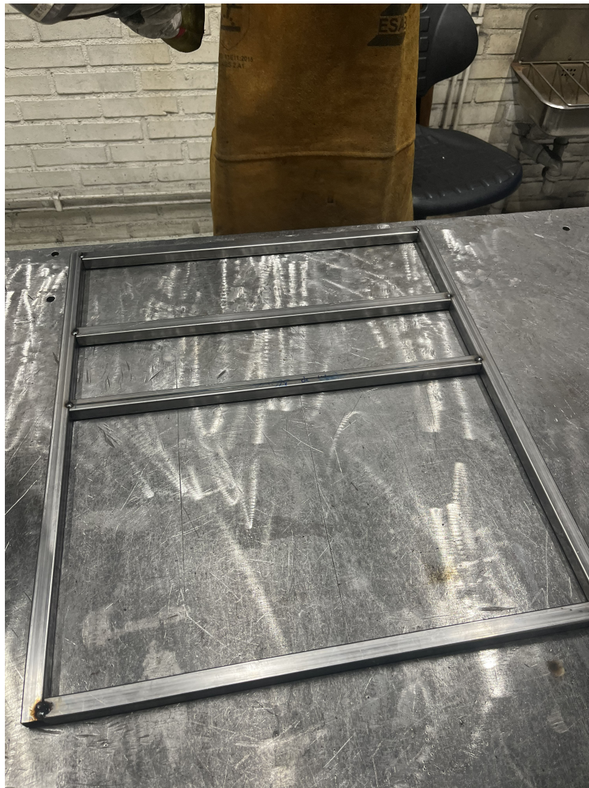
Figur 5.11: Ramkonstruktion i stål under tillverkningsprocessen. Tvärgående balkar är punktade för att skapa en stabil struktur.
