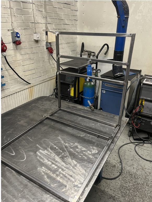
(a) Montering av ramens sidostruktur.
