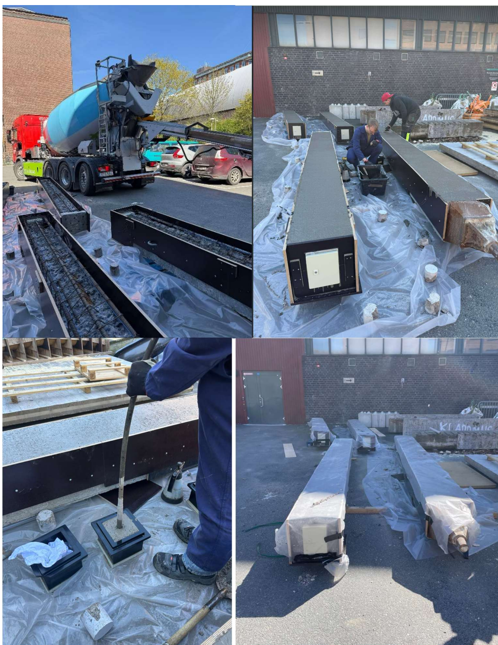
Figur 7.9: Gjutning (Egna bilder, 2025)
