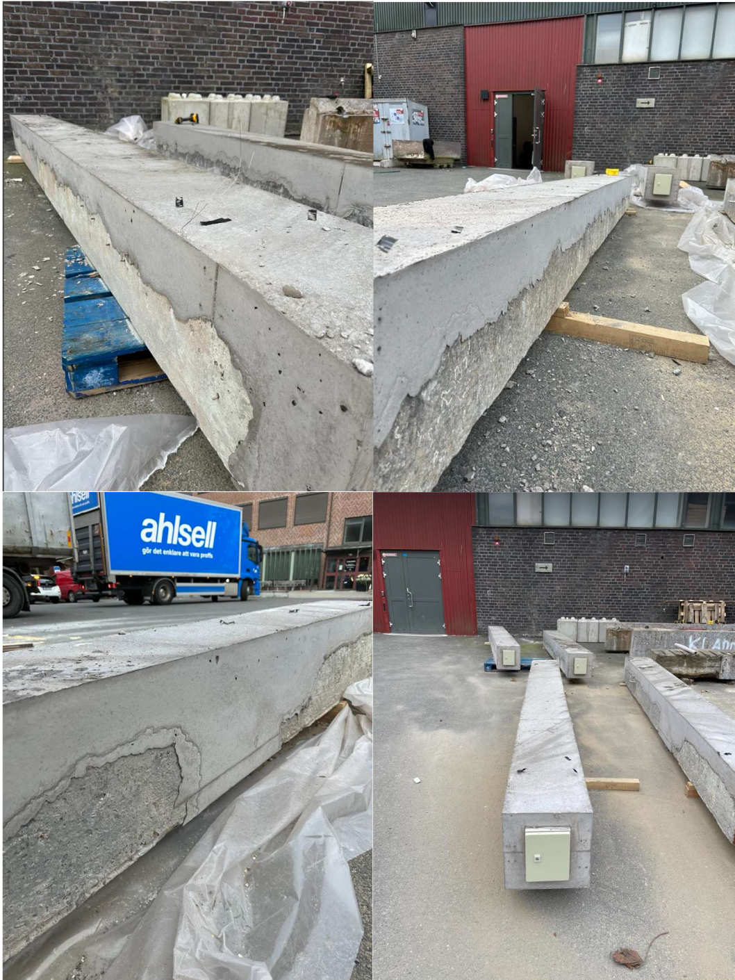
Figur 7.10: Slutresultat gjutning (Egna bilder, 2025)
