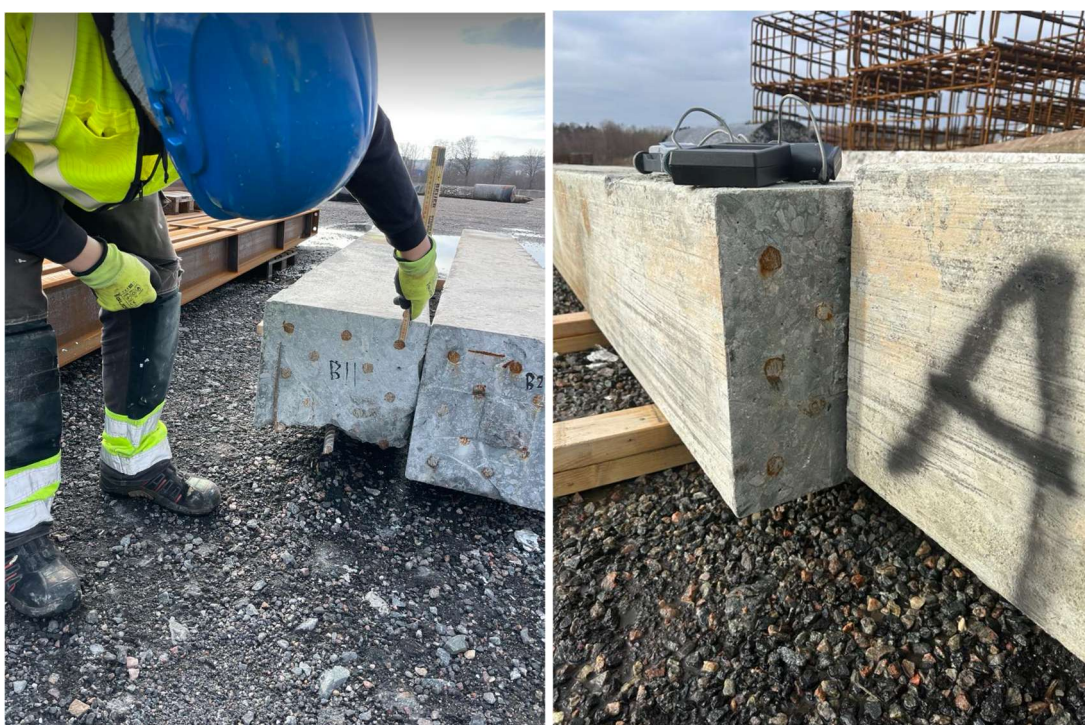
Figur 7.1: Täcksiktsmätningar (Egna bilder, 2025)
