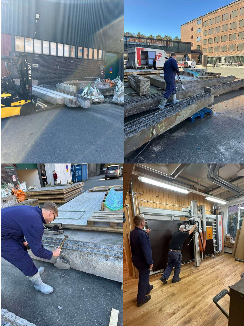
Figur 7.5: Förberedelser inför formbyggnation (Egna bilder, 2025)
