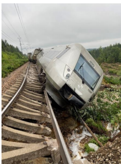
Figur 3.3: Urspårning av tåg på Ostkustbanan mellan Iggesund och Hudiksvall. En tydlig erosion av järnvägsbank på grund av kraftigt vattenflöde. Man skimtar även en avverkning i bakgrunden. (Statens haverikommission, 2024), CCBY 2.5 SE
