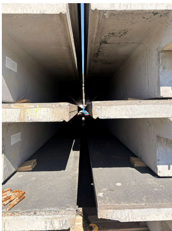
Figur 8 TT-kassett framifrån med skåror för fästning av vattenränna. (Författarens egna bild)
