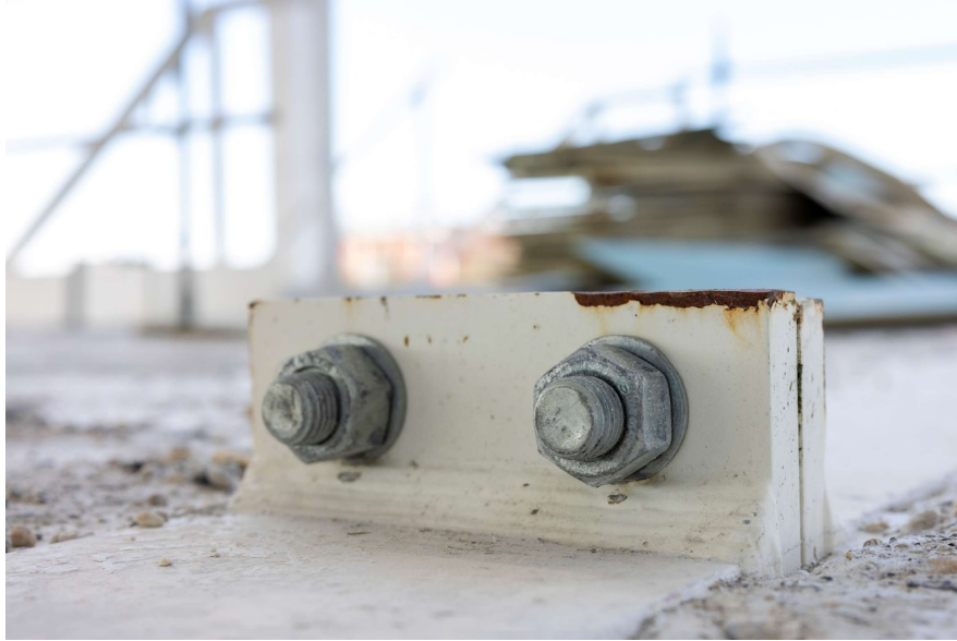
Figur 2 Bultförband som sammanbinder byggnadens stålbas och bär upp betongelementen. (Koggel, 2025). Foto: Marlie Koggel för HMO.nl.
