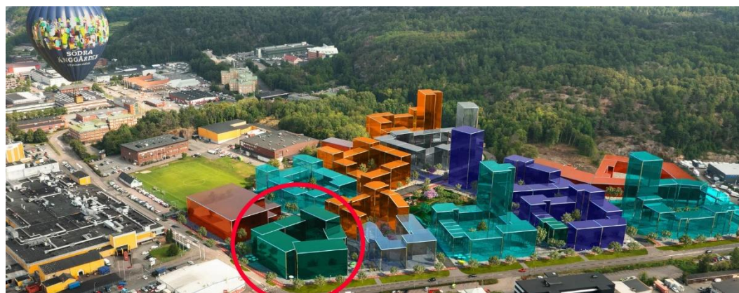
Figur (3.1). Södra Änggården, en ny stadsdel intill Änggårdsbergen (Bonava, u.å.)
