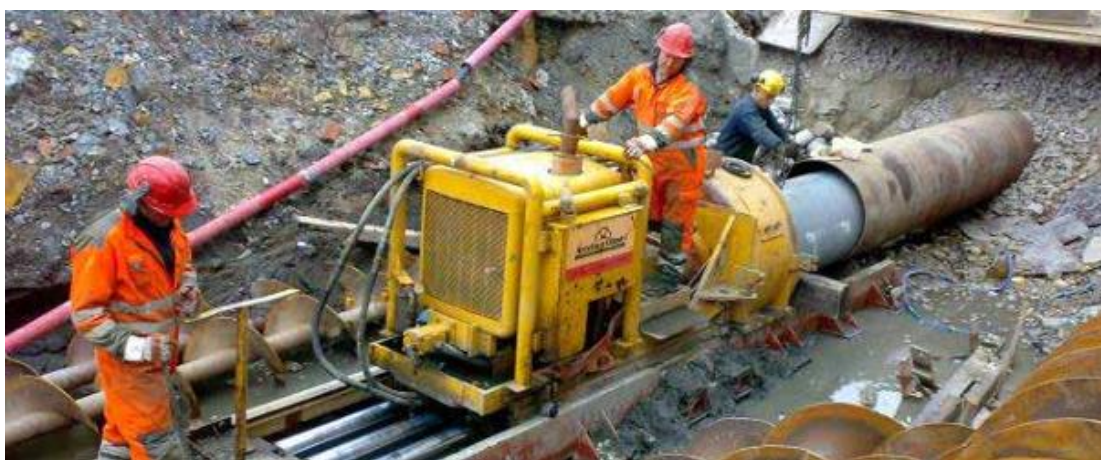
Figur 7. Rörtryckning i Norge. (Norsk Vann, 2016). Återgiven med tillstånd.
