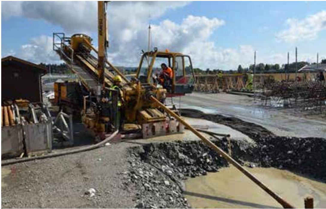
Figur 9. Förnyelse genom borrhning i Norge. (Norsk Vann, 2016). Återgiven med tillstånd.
