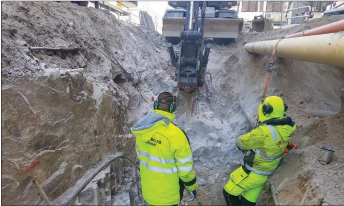
Figur 5. Pågående schaktning för VA-ledning i Eskilstuna, där berggrunden får borrar bort. (Spjuth, 2018). CC-BY 4.0
