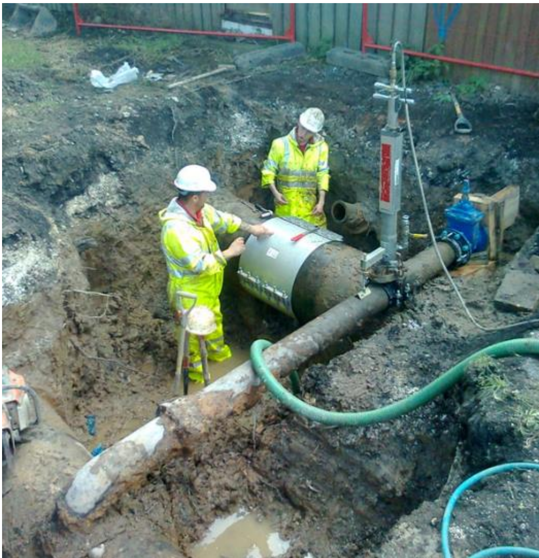
Figur 4. Reparationsmuff appliceras på en vattenledning av gjutjärn med dimension 610 millimeter i Hull, Storbritannien. (Cascade Clamps, 2011). CC BY-NC-ND 2.0
