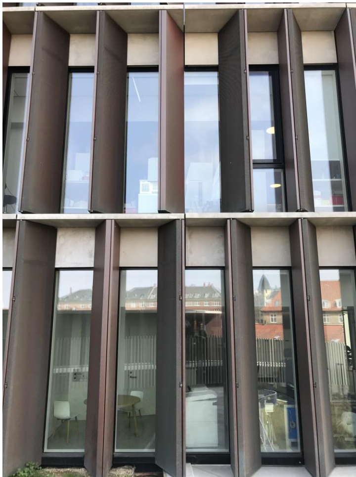
Figur 4.1. En närbild på lamellerna på Maersk Towers fasad.
