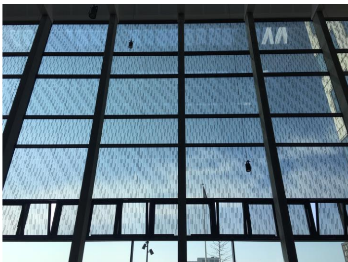
Figur 4.7. Visar glasfasaden med microshade-lösning på Sweco i Köpenhamn.
