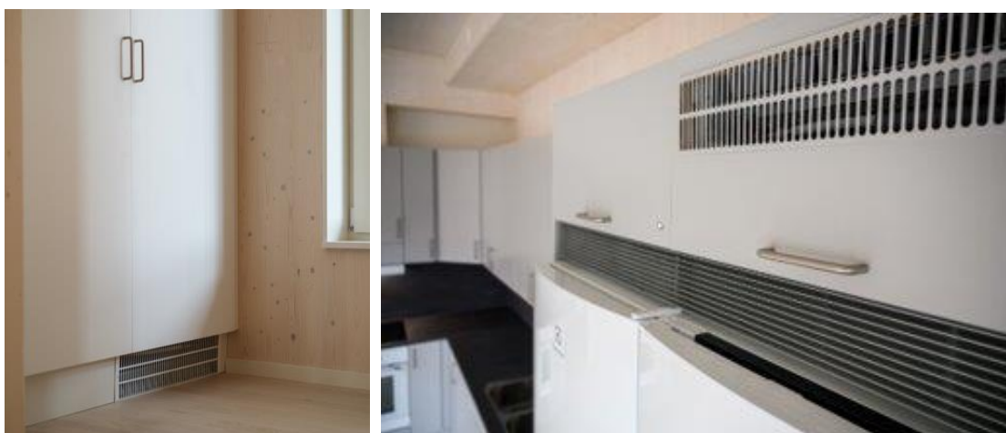
Figur 6 De två bilderna visar hur Parasockeln kan placeras och hur de ser ut med galler.
