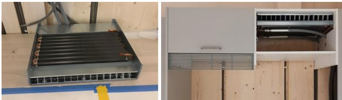
Figur 5 Bilden till vänster visar Parasockeln oinstallerad. Bilden till höger visar en Parasockel som är installerad men utan galler.
