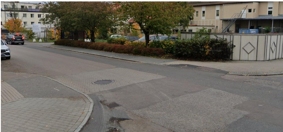
Figur 19: Korsning mellan Nygatan och Gymnasiegatan med upphöjd trottoar. (Google Maps, 2022).
