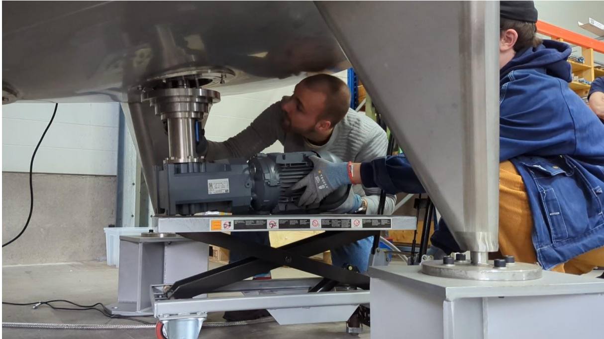
Figur 16 Montering med lyftbord.
