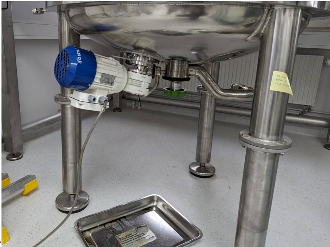
Figur 11 Bild på botten av tank med utlopp, givare och drivenhet.
