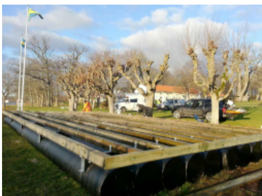
Figur 7. Rörponton av polyeten Alfabryggan (u.å)
