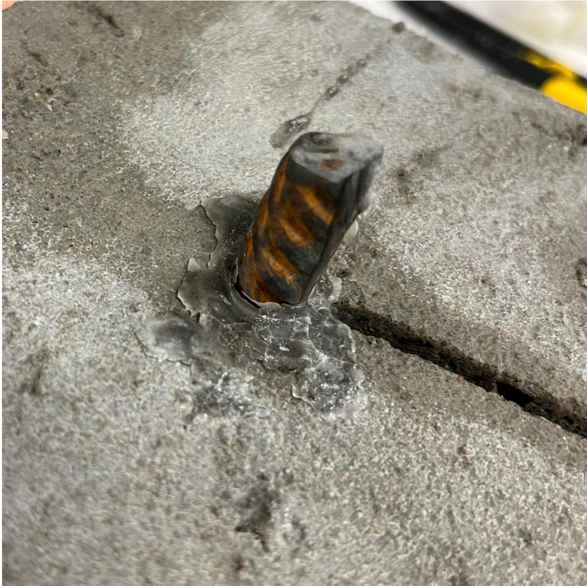
Figur A3.7: Tätning runt armering med stearinljus och tändare.
