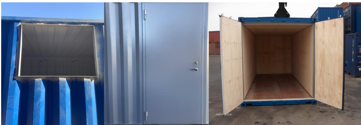
Figur 4 Skuret och efterbearbetat hål i container (vänstra bilden), färdigmonterad gångdörr på långsidan av en container (mitten bilden) och en färdig isolerad 20fots container utan belysning och elcentral (högra bilden) som är erhållen ur företagets arkiv.
