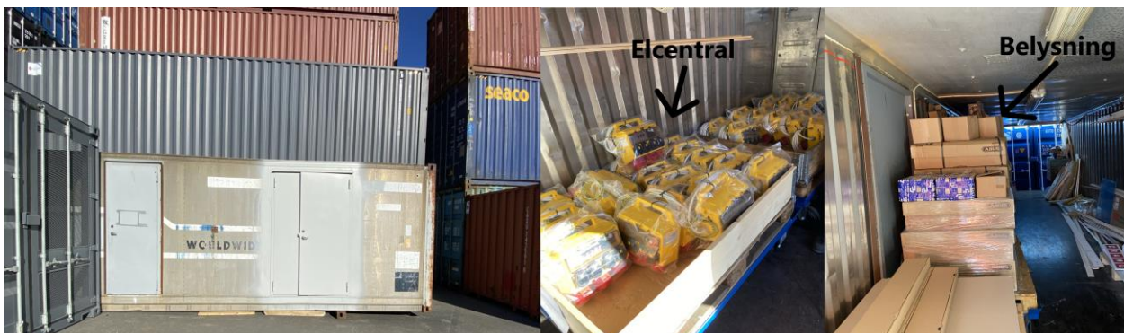
Figur 11 Containerlagret med elcentral & belysning. Containerlagret (vänstra bilden), elcentralerna (mitten bilden) och belysningen (högra bilden).
