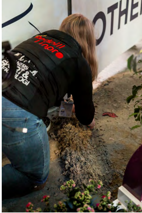
Figur 10: Nedgrävning av kabel utmed sargen under GHS
