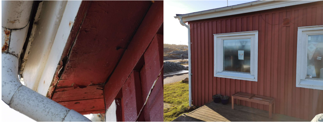
Figur 1.6 Till vänster; Takutsprång. Till höger; Fasad utanför testrum åt NV.
