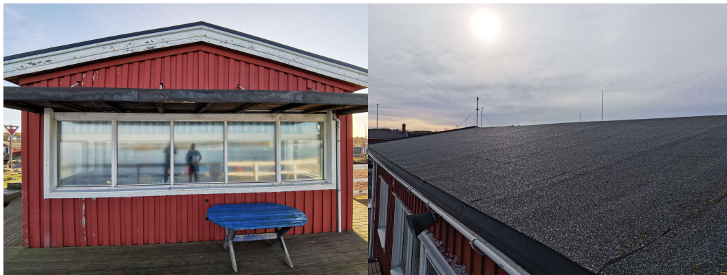
Figur 1.8 Till vänster; Fasad åt NV, fönsterband och skärmtak. Till höger; Tak.
