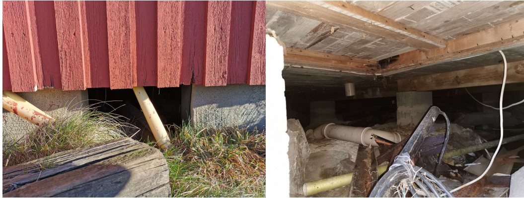
Figur 1.3 Till vänster; Sockel och kryplucka till krypgrund. Till höger; Inuti krypgrunden
