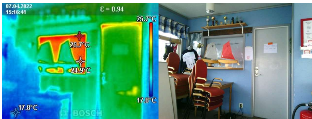
Figur 6.3 Bild av Testrummet sett utifrån från Salen. OBS. köldbrygga vid kiosklucka och innerdörr.
