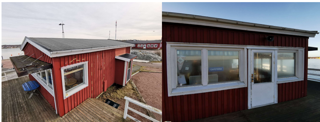
Figur 1.7 Till vänster; Tak. Till höger; Fönsterband åt NÖ.
