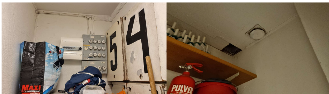
Figur 2.4 Till vänster; Inuti förråd, proppskåp. Till höger; Förråd, friskluftsventil, inspektionshål.
