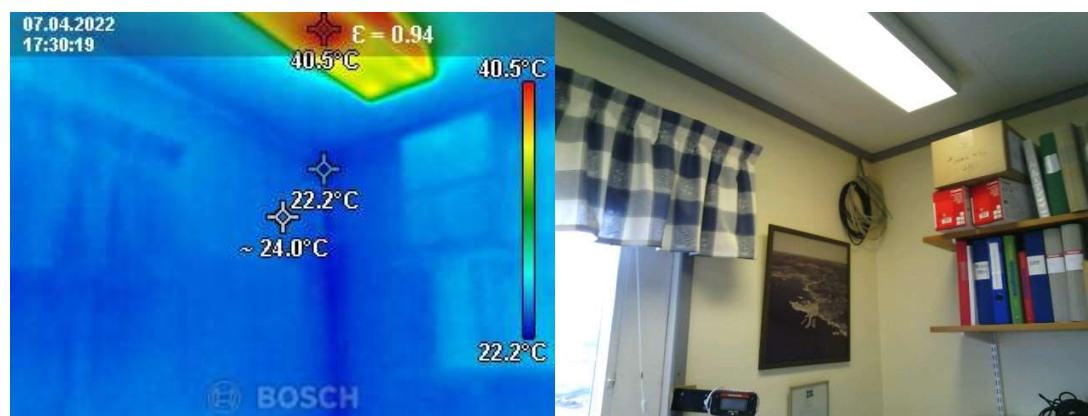
Figur 5.6 Termografisk bild på ett av testrummets hörn under Blower door test.
