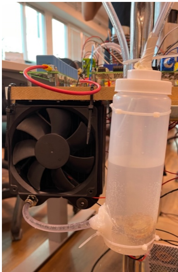
Figur 3.12: Kylningen av växelriktaren bestående av en vattenreservoar, radiator och pump
