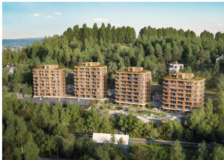
Figur 9: Fyrstikkbakken 14 är belägen i Oslo och innefattar fem huskroppar konstruerade med hjälp av KL-trä ( Fyrstikkbakken 14, Oslo , u. å.)
