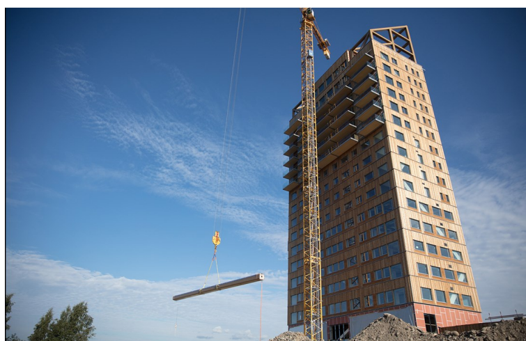
Figur 10: Vid upprättande var Mjøstårnet världens högsta träbyggnad, byggnaden reser sig 85,4 meter över marken i Norge (Crocetti, 2018)
