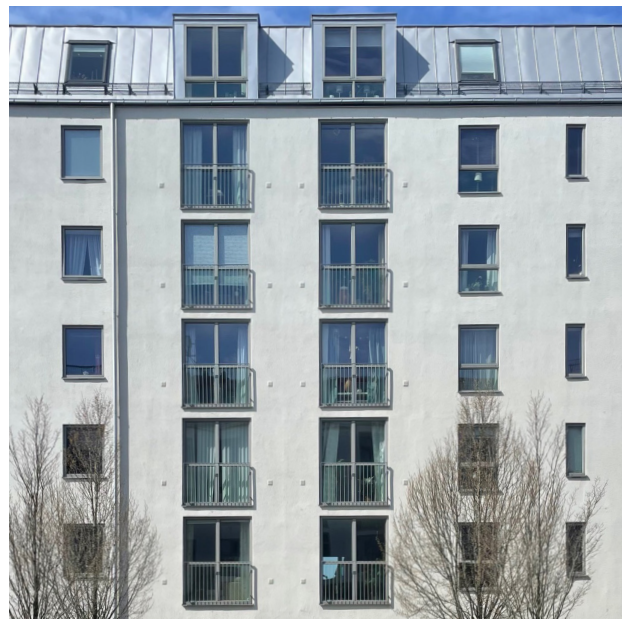
Fig. 9. Image facade, Söderstaden.
