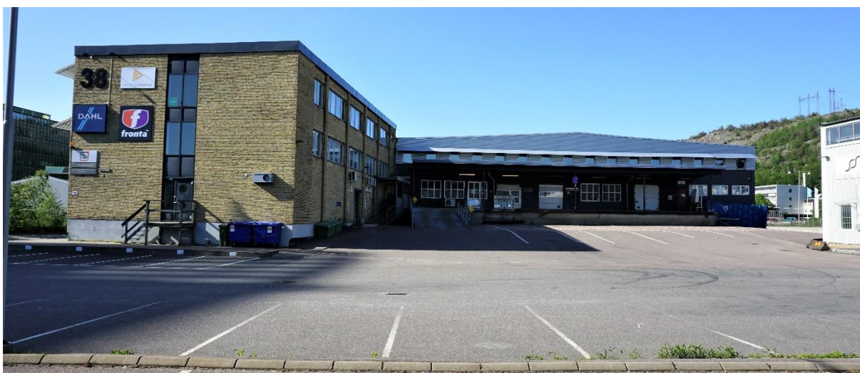
Figur 3.4: Bild mot byggnadens södra fasad. Tegeldelen till vänster innehåller kontor och sitter ihop med lagerdelen.
