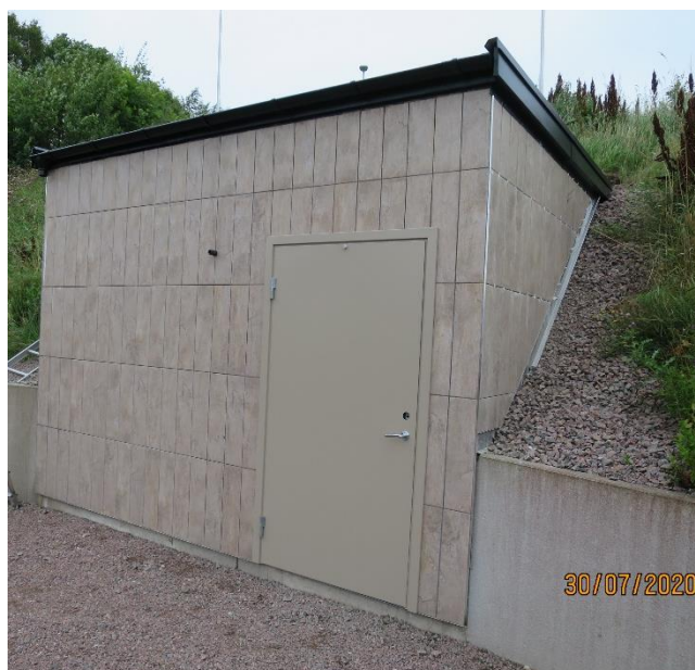
Figur 2.6: Vätgasförrådet i betong utifrån.
