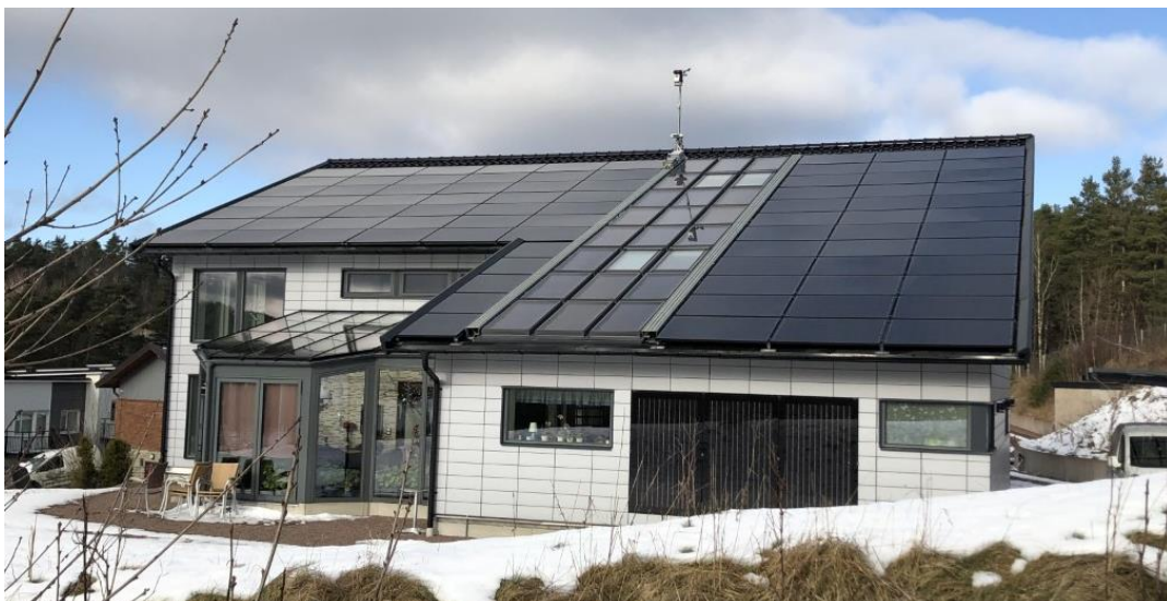
Figur 2.1: Huset från utsidan med solpaneler på taket mot söder samt i fasaden (mellan fönsterna åt höger).
