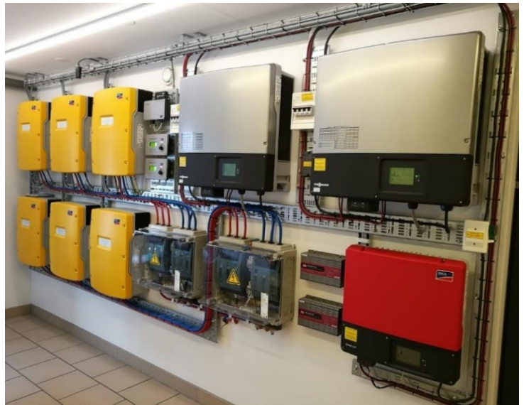
Figur 2.8: Vägghonterade styrsystem med växel- och likriktare.
