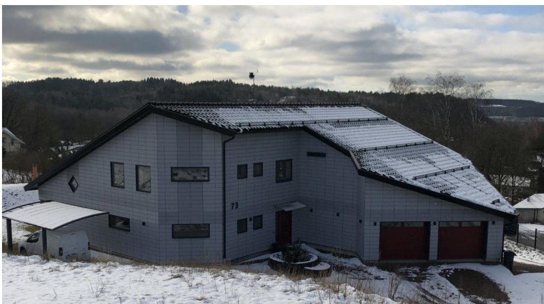
Figur 2.2: Översiktlig bild mot husets nordöstra sida.
