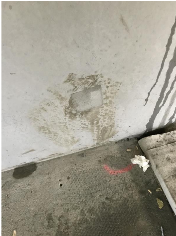
Figur 21. Slutligen fogas hålet igen (Egen bild).
