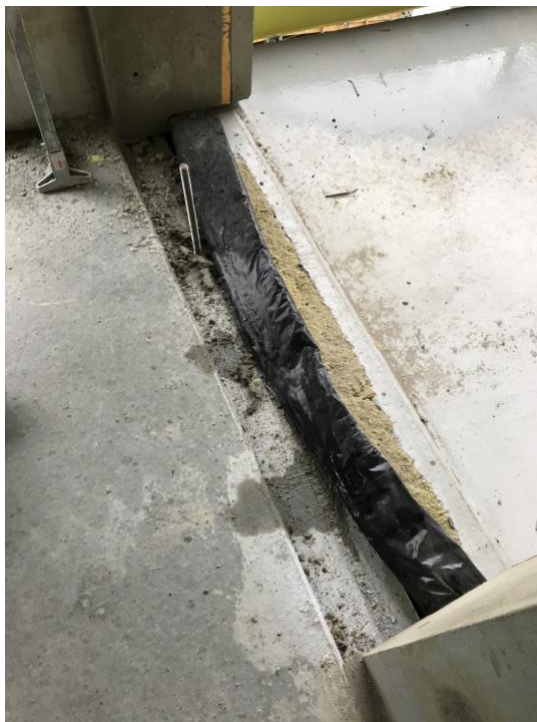
Figur 18. Gängstång i element (Egen bild).
