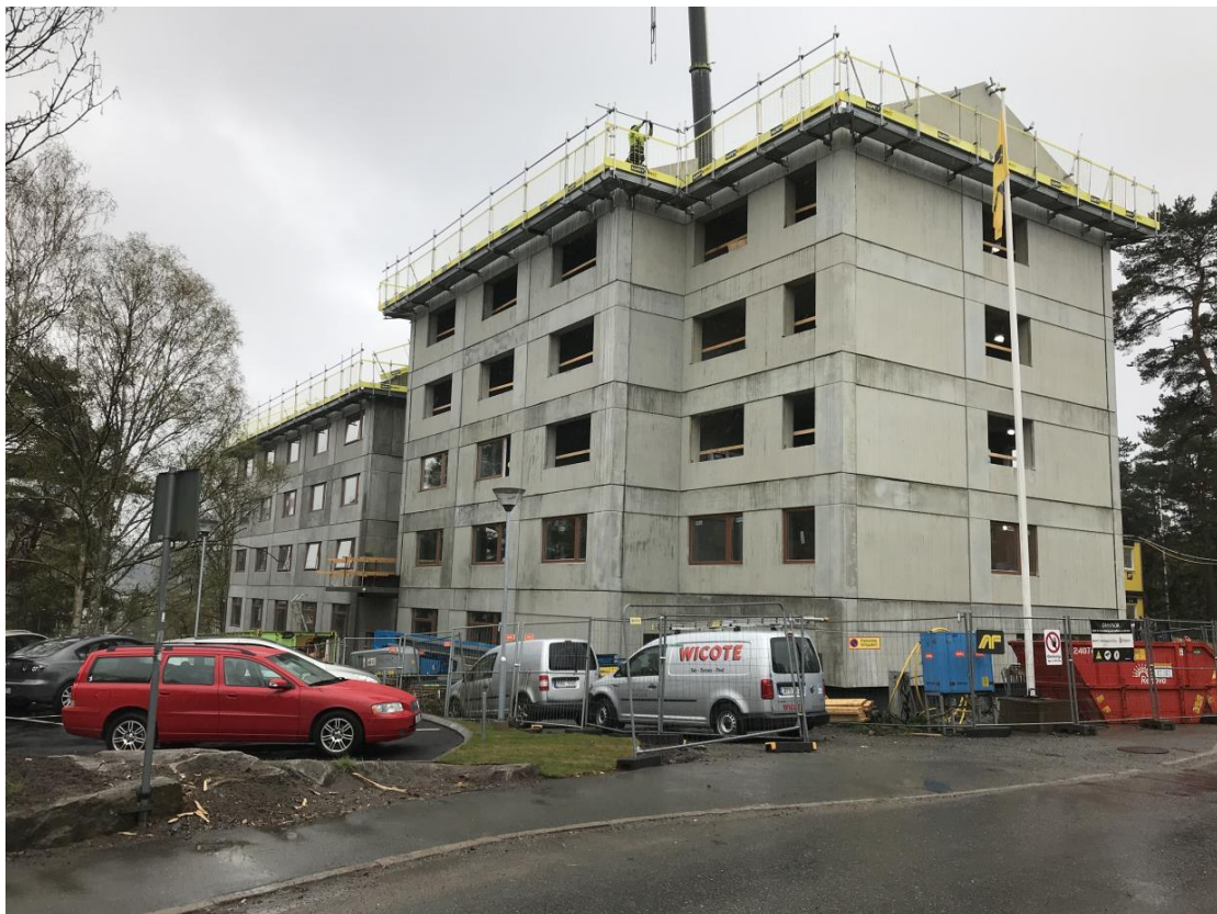
Figur 1. Betonghuset i nästan färdigmonterat skick (Egen bild).
