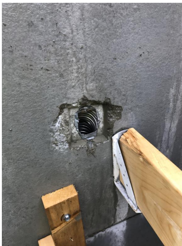
Figur 19. Hålet varifrån gängstången gjuts in (Egen bild).
