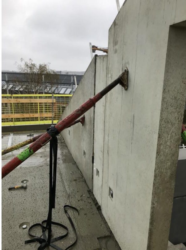
Figur 20. Stag på plats för att stabilera väggen under byggtiden (Egen bild).
