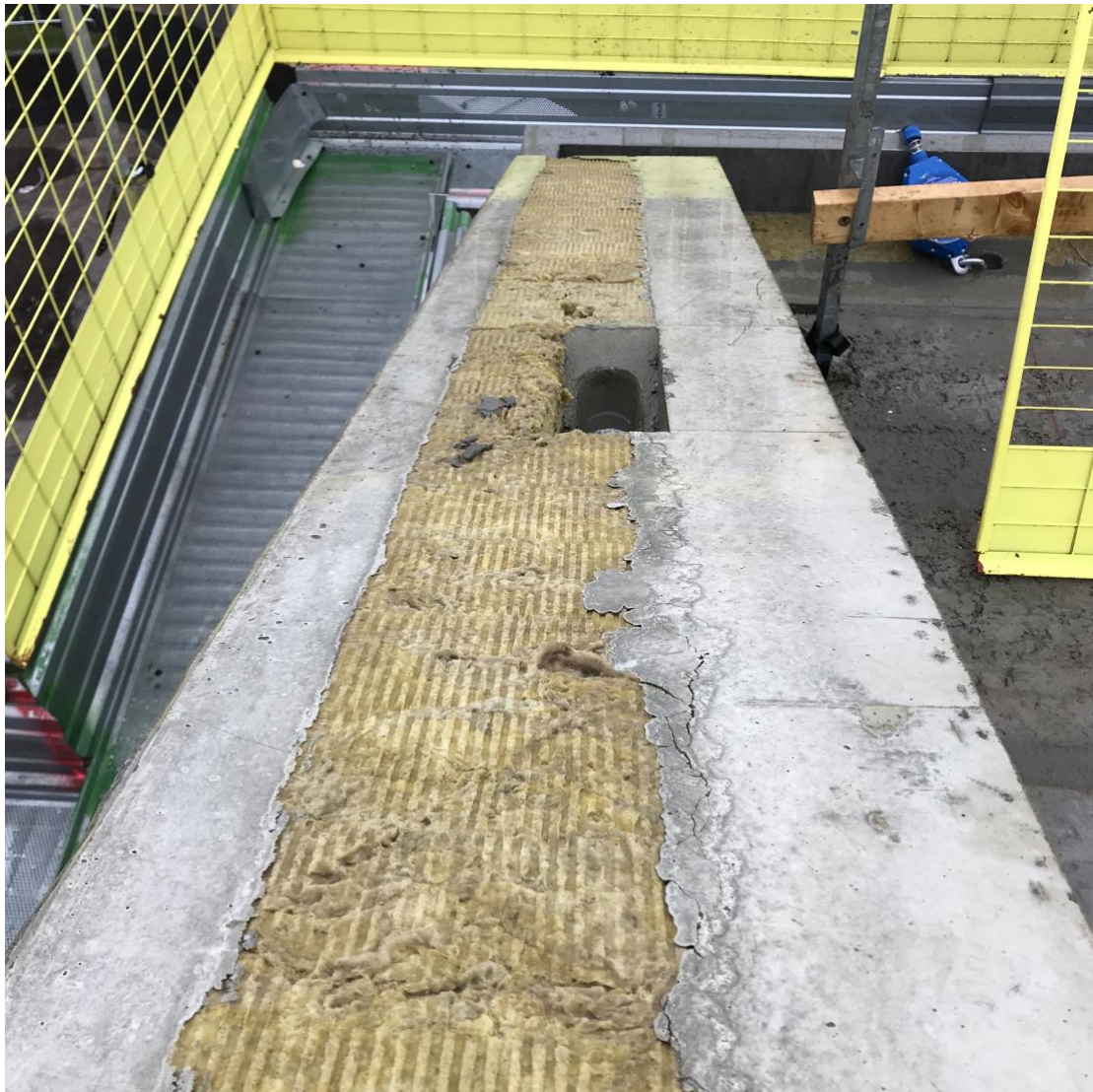
Figur 15. Sandwichvägg som yttervägg (Egen bild).
