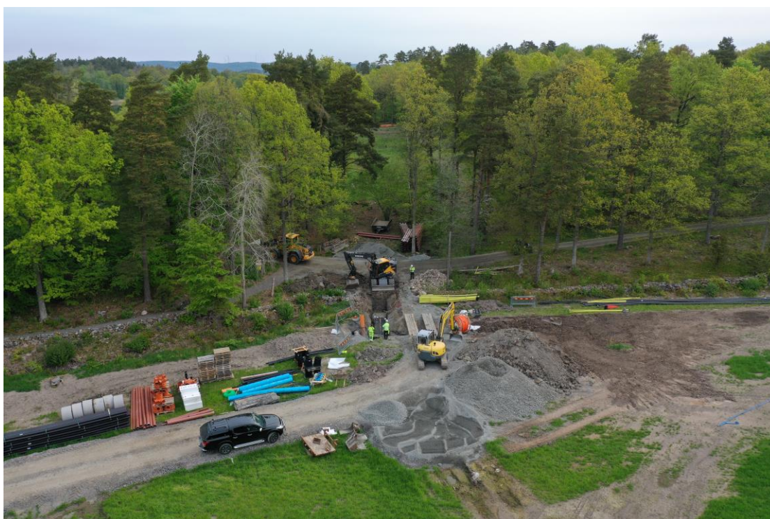
Figur 4.1 Drönbild från en del av projektet Västra Bodarna.
