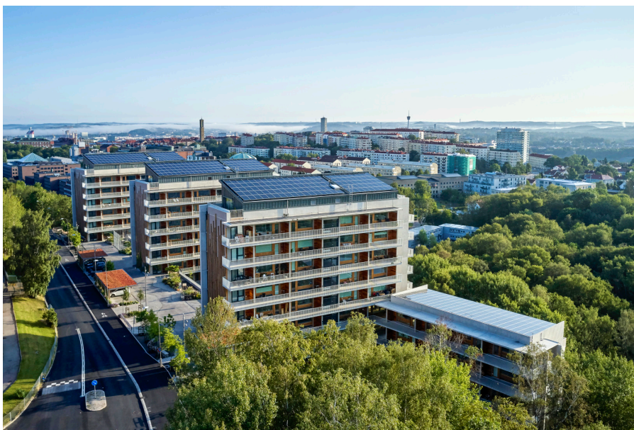
Figur 2. Flygfoto över Riksbyggens Brf Viva på Guldheden taget av Ulf Celander som visar de tre huskropparna som Viva består utav med balkonger samt solcellerna på taket. Man ser även delar av Johanneberg, Göteborg i bakgrunden. (Hämtad 2020-03-25).
