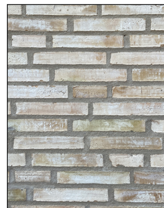
Fasaden består av smala tegelstenar utan regelbunden murning.
