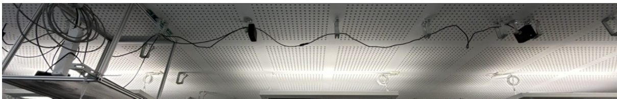
Figur 2.2: Två av de fyra Kameror monterade i taket inkopplade till datorn till vänster.
