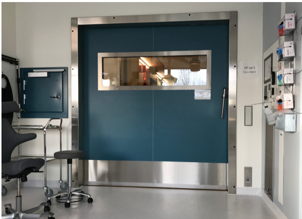
Figur 3.4: Passager till- och från operationssalen sker genom en skjutdörr. Till vänster i figuren återfinns en genomsträckningslucka för förflyttning av enstaka föremål in- och ut från salen.
