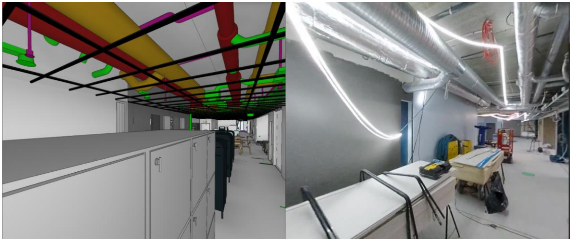
Figur 4.8 Visualisering av 3D-modellen i Dalux till vänster och en verklig bild av samma plats under byggskedet till höger.
