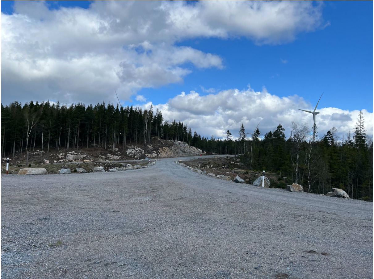
Figur 4, Transportväg vid Rödene vindkraftpark (Andersson & Nordell, 2023).
