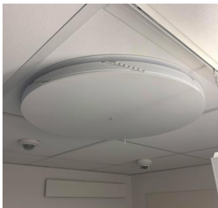
Figur 2 Bild på tilluftsdon TTC och överluftsdon till korridor.
