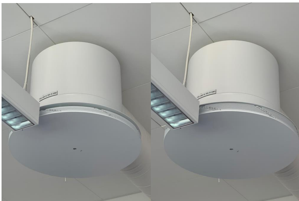
Figur 27 Tilluftsdon med visuellt synliga stängda respektive öppna spjäll.
