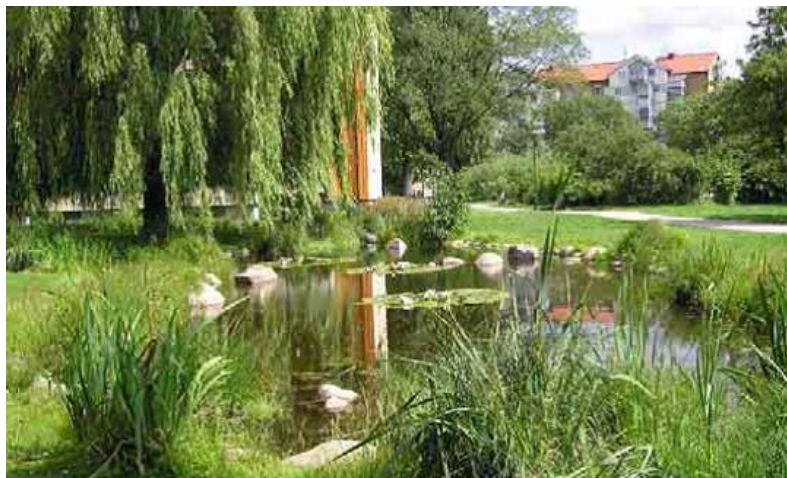
Figur 4. Dagvattendamm på en grönyta i Augustenborg. Att anlägga kanaler och dammar i den befintliga miljön var utmanande men kunde utformas så att de tillförde estetiskt värde till utemiljön. Foto; VA-syd. ( https://www.smhi.se/klimat/klimatanpassa-samhället/exempel-pa-klimatanpassning/oppen-dagvattenhantering-i-malmostadsdelen-augustenborg-1.115720 ) Godkänd för användning.
