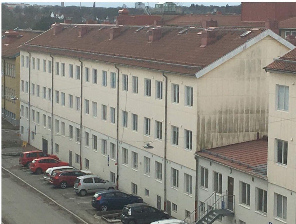
Figur 6 Bebyggelse i Källtorp före ombyggnad. Fasaden klädd med asbetsplattor. Foto Paula Femenias
