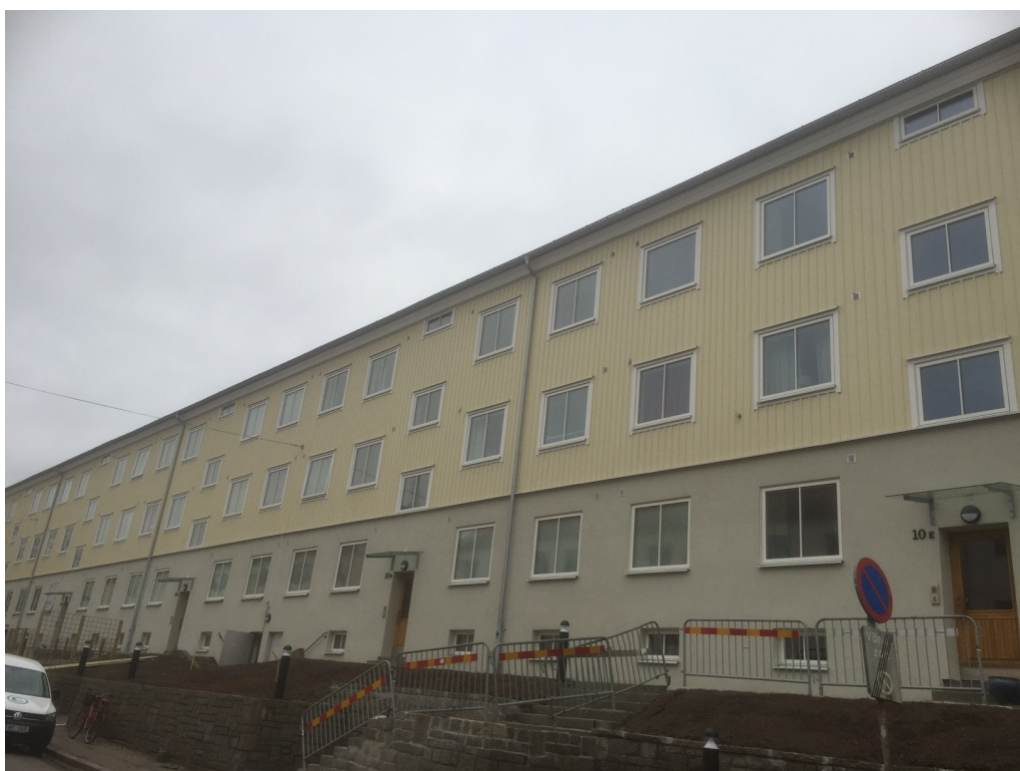
Figur 7 Qvidingsgatan 10 efter ombyggnad. Ny träfasad och nya fönster. Foto Klara Mörk
