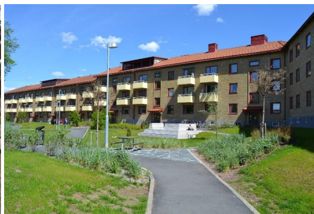
Bild 4. Visar hur parken ser ut efter byggnation, bilden är tagen 21 maj 2020
