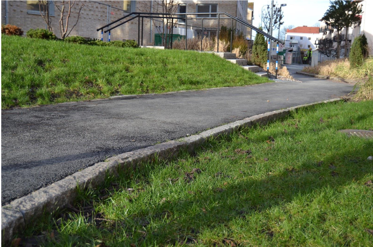
Bild 10. Visar en del av gångstråket som saknar en upphöjd stödkant, detta i syfte att avleda dagvatten.
