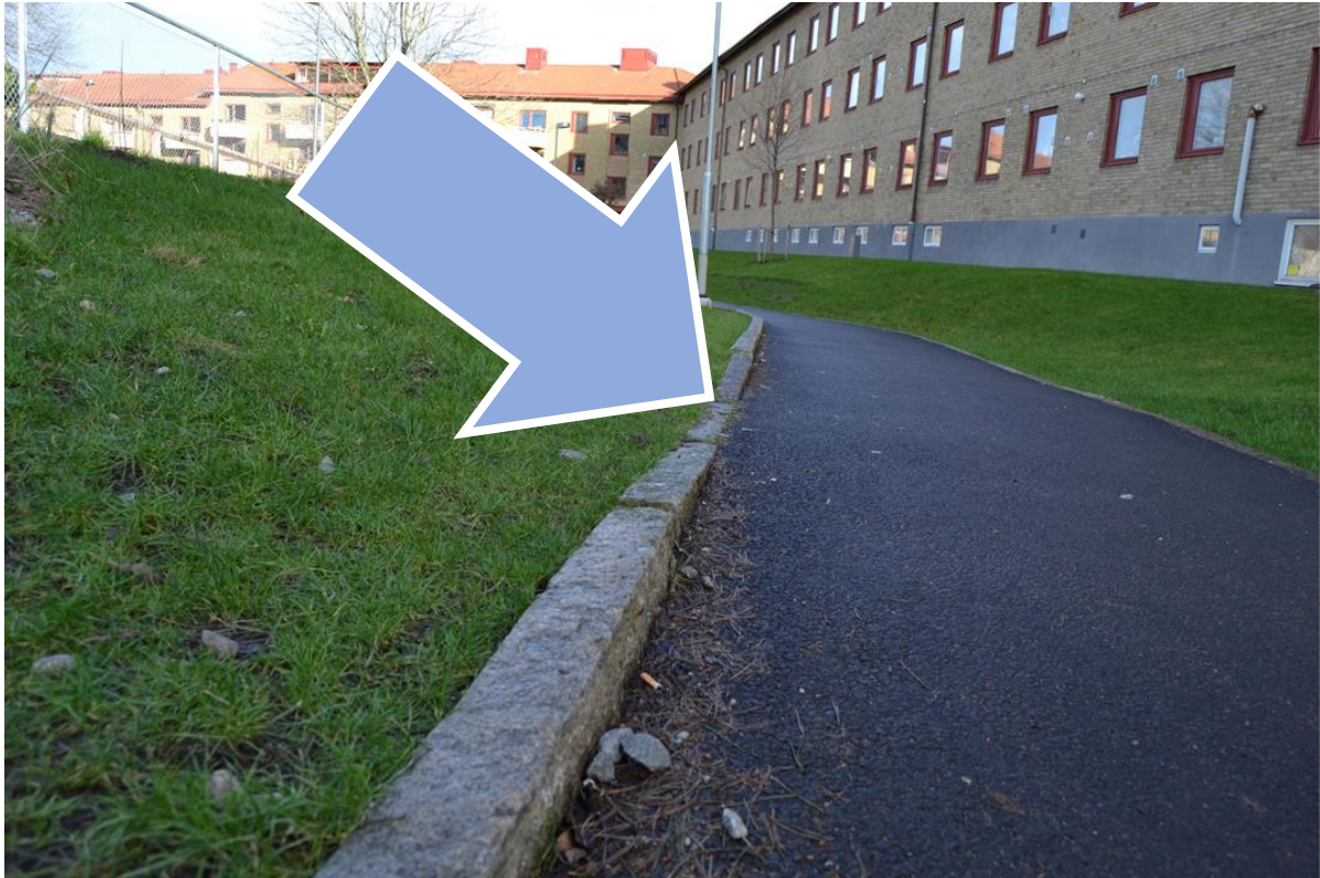
Bild 11. Visar en stödkant till ett gångstråk, där pilen markerar en försänkning som har syftet att avleda dagvatten.
