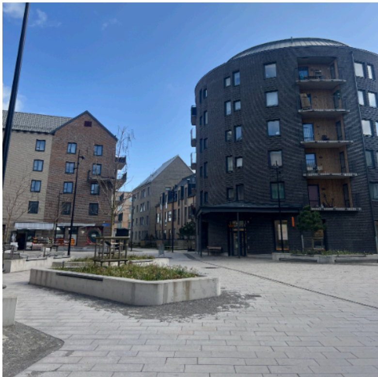
Figur 28. Varierande höjder och former på byggnader (Ekman & Valberg. 2024-04-10).
