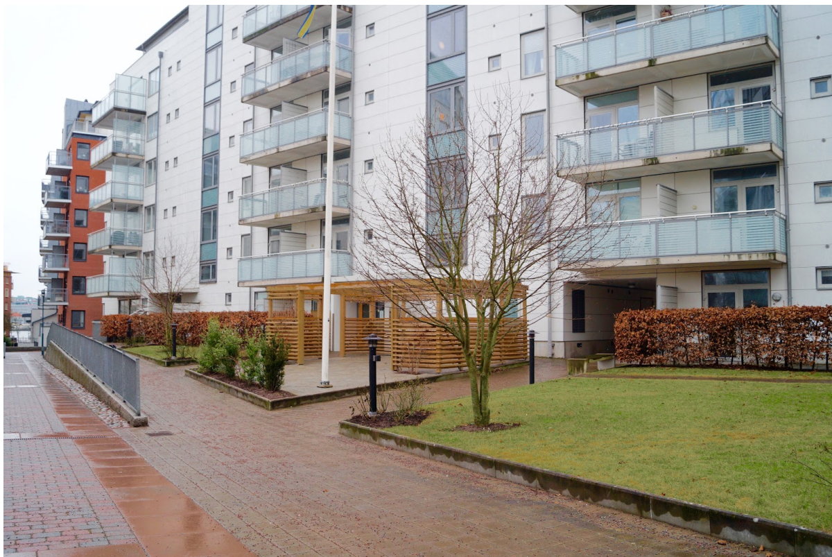
Figur 26. Ramper och trappor används på grund av höjdskillnaden.
