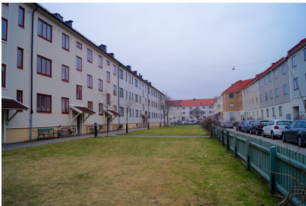
Figur 14. Innergård med parkeringar utmed vägen.
