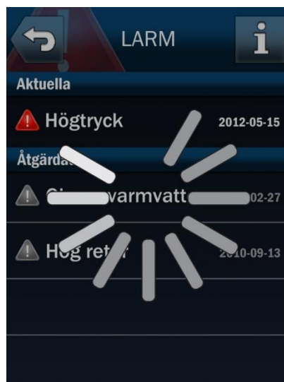
Figur 5.36 – Omstart av värmepump.
