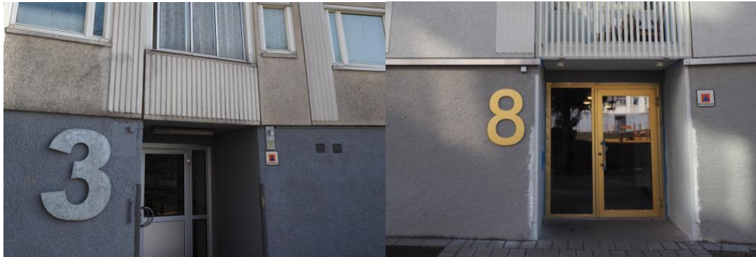
Bild 3 och 4: Entré före & efter renovering. Källa: Författarnas egna bilder.
