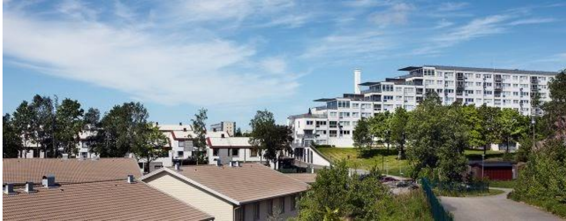
Bild 12: Hus A ombyggt i Östra Gårdsten. Källa: Gårdstensbostäder. Publicerad med källans tillstånd.
