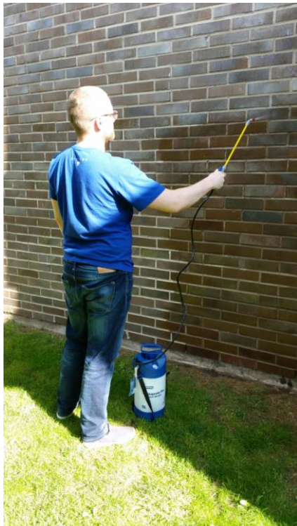
Figur 1 Bild som visar hur en hydrofob ytbehandling appliceras.. Författarens egen bild.
