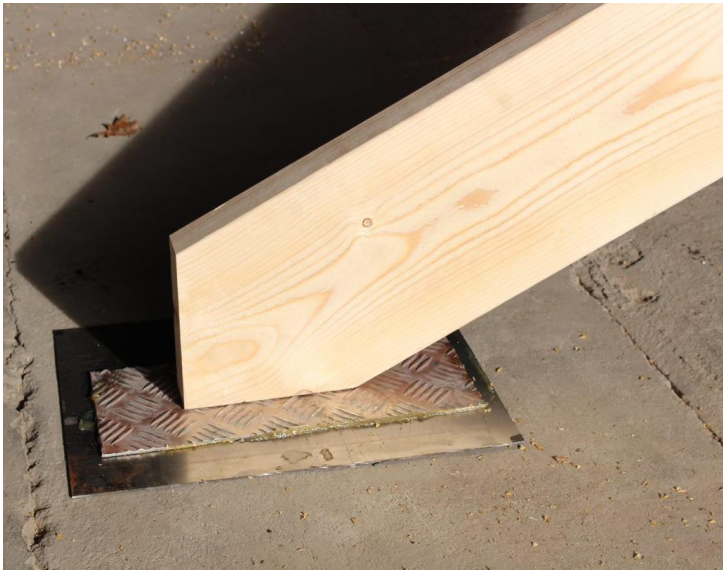
Figur 16. Fritt upplag på metallplåtar med kullagerfett.
