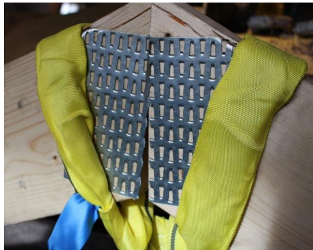
Figur 25. Brott i spikplåt vid 4491 N.
