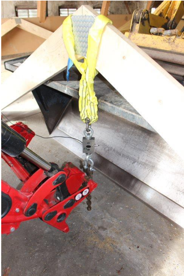
Figur 20. Kranvåg sammankopplad med takstol och traktorns gaffeljärn.
