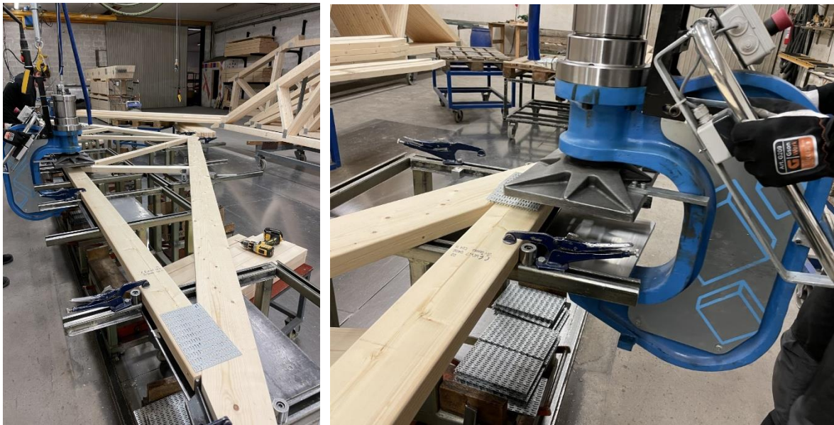
Figur 6 och 7. Monteringsjigg och spikplåtspres.
