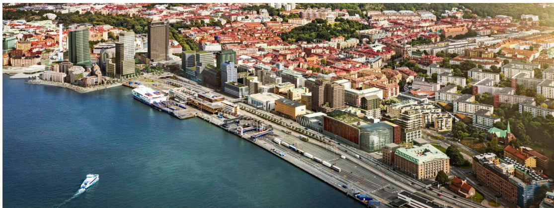
Figur 3, Visionsbild över Masthuggskajen vy från Göta älv (Bildkälla: Kanozi arkitekter, 2018). Återgiven med tillstånd
