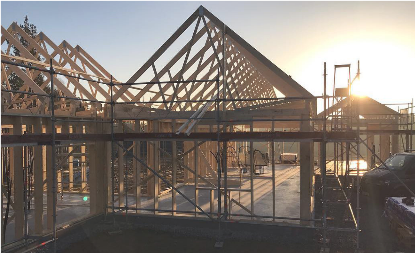
Picture 9. Stud frame timber structure, source: OCH Thermé.
