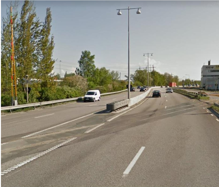
Figur 28. QuadGuard CEN, rak modell. Borttaget bomdriv. Ny bom på skyddad sida som täcker hela körbanan i sin riktning (Google Maps, 2016).
