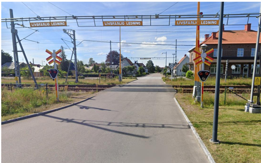
Figur 8. Två helbommar som täcker hela körbanan (Google Maps, 2019).
