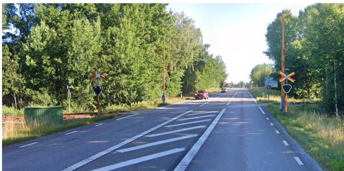
Figur 62. Foto från syd. Tåget kommer från öster till väster från fotot (Google Maps, 2020).
