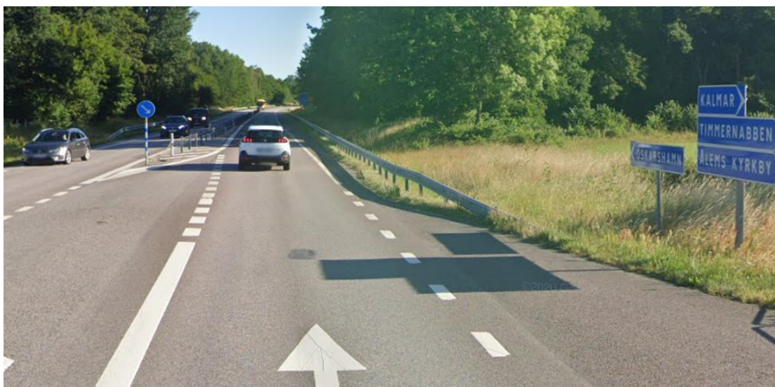
Figur 22. Neddoppad vägräckesände med liten utvinkling, hastighetsgräns 80 km/h (Google Maps, 2020).
