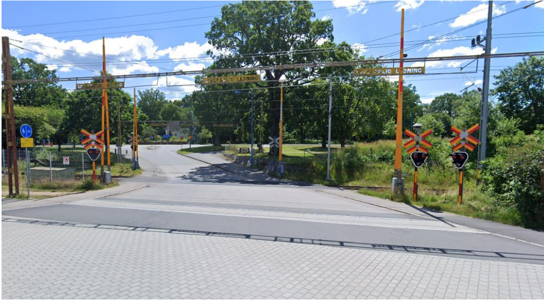
Figur 7. Helbommar med två kortare armar som täcker hela körbanan (Google Maps, 2019).
