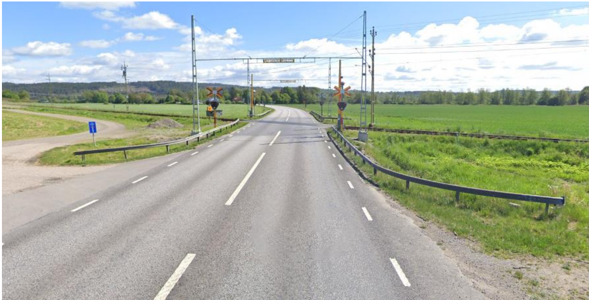
Figur 16. Exempel på en plankorsning med sidoräcke som skyddar mot oeftergivliga anordningar (Google Maps, 2019).
