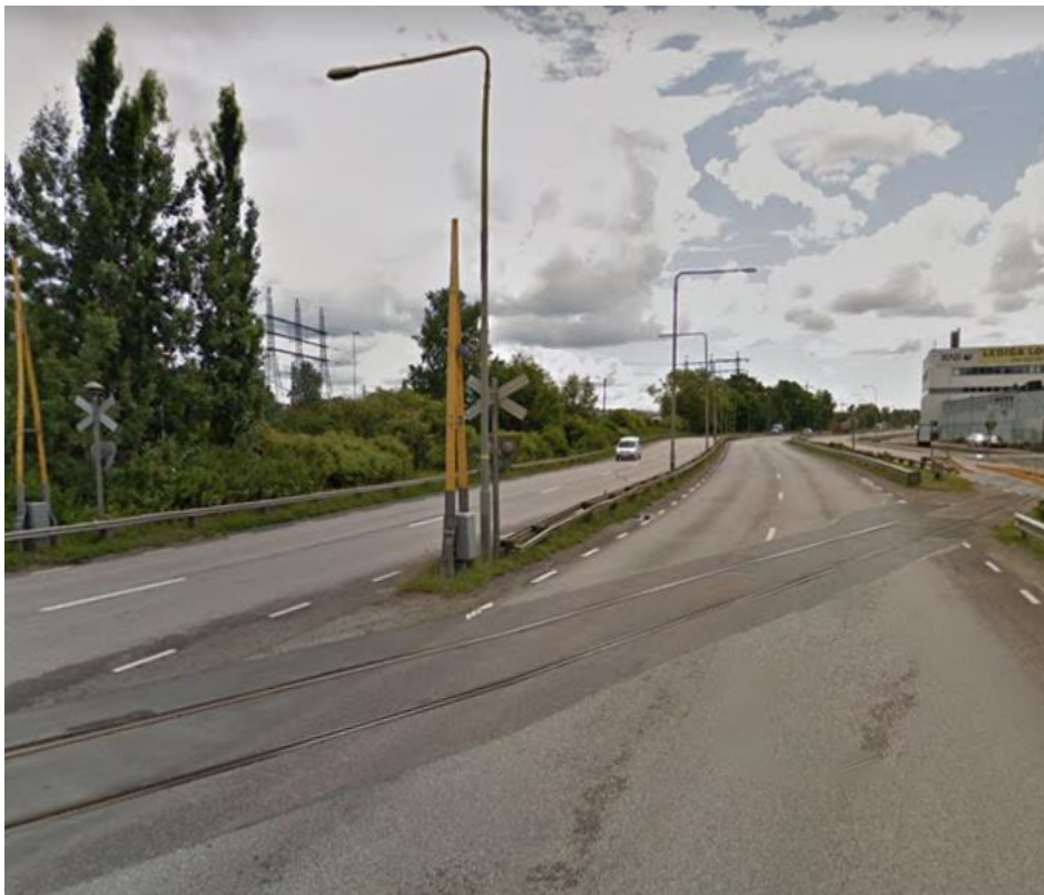
Figur 27. Oskyddat bomdriv på mellan vägbanor (Google Maps, 2014).
