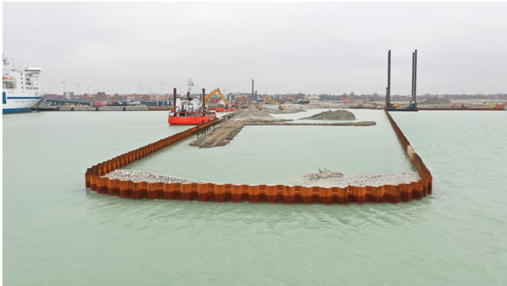
Figur 3.1: Bild från referensprojektet i ett tidigt byggskede. Källa: PEAB. Hämtad 2023-01-02.
