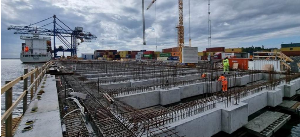
Figur 3.6: Bild från byggskedet utbyggnation Pampushamnen. Källa: PEAB. Hämtad 2023-01-02.
