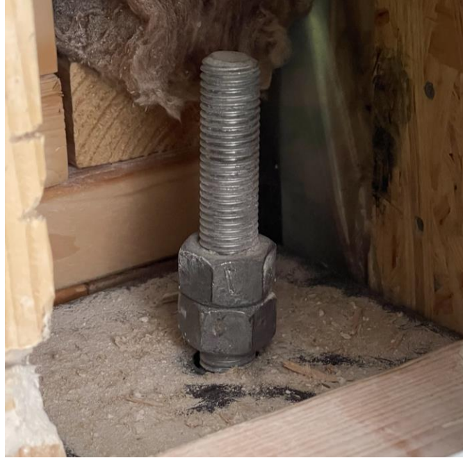
Figur 16. Åtdragningsändan i ett dragstag.
