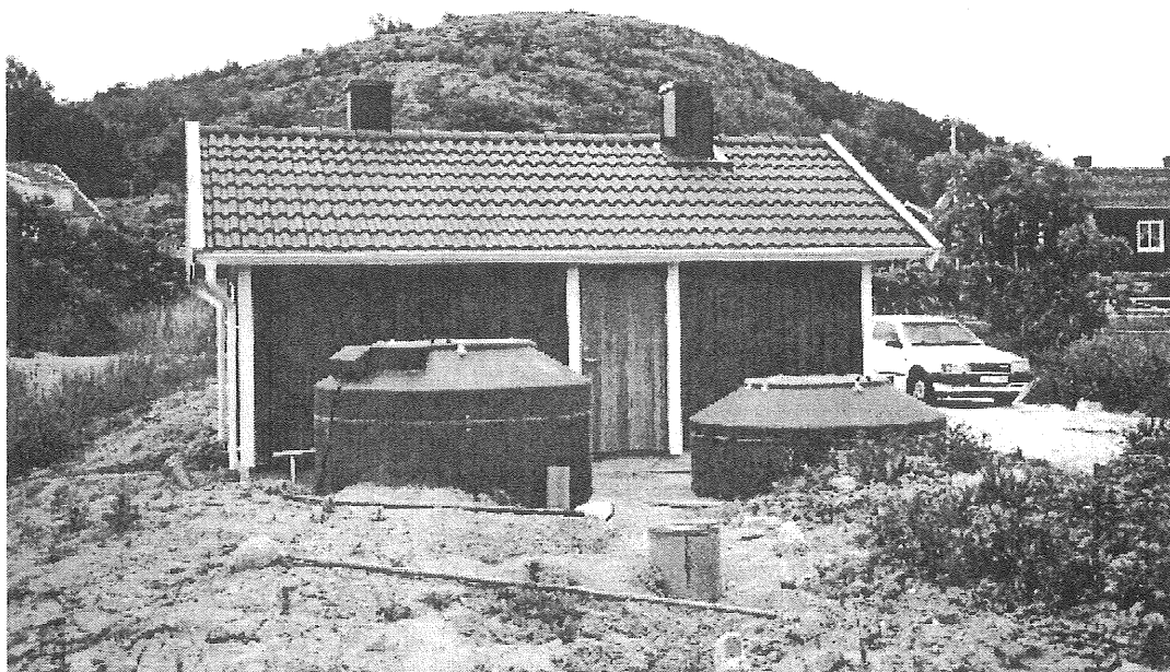
Figur 5.5 De två biobäddarna utanför reningsverket i Södra Valsäng. Biobädd 1 är till vänster i bild.
