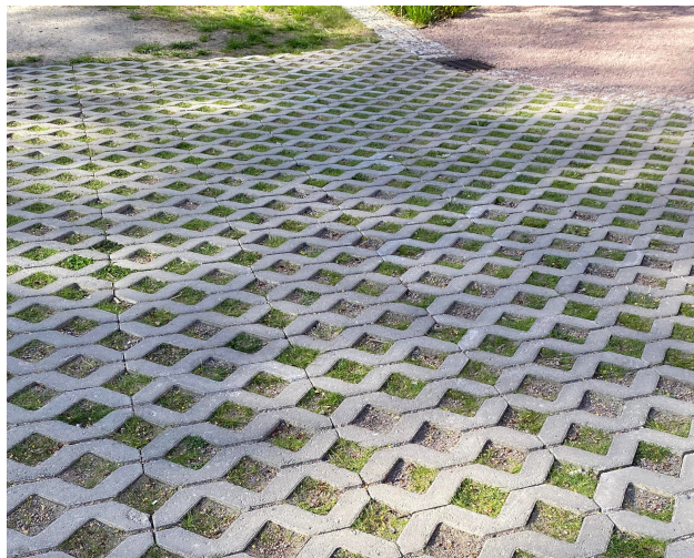
Figur 15: Genomsläpplig beläggning utanför Science Park mot Sven Hultins gata. Foto: Emma Turesson
