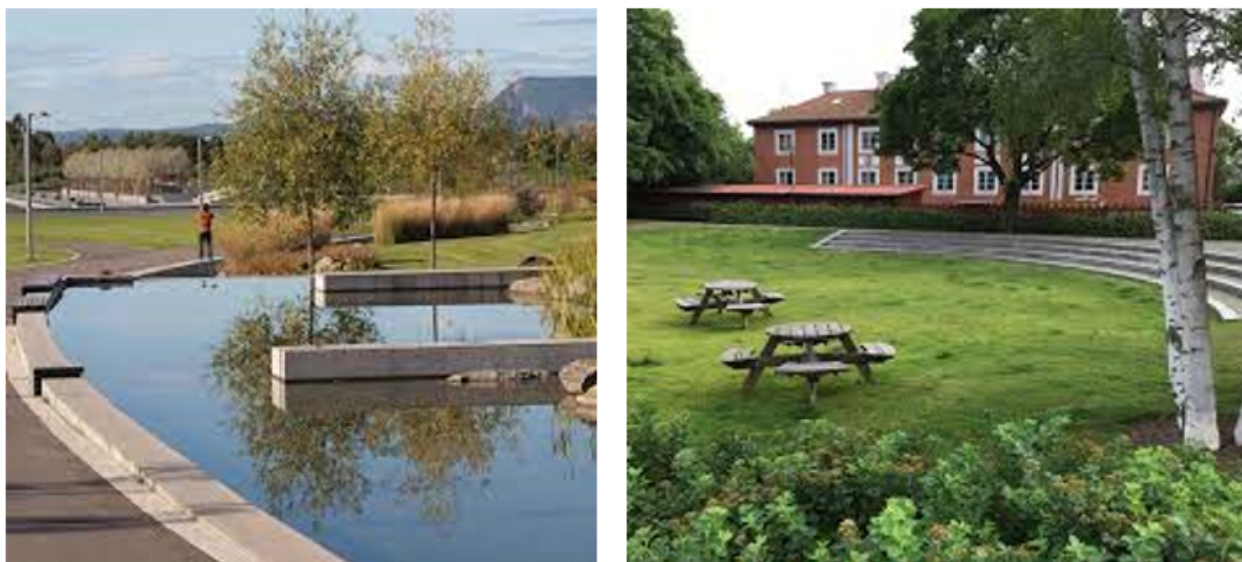
Figur 13: Till vänster visas en våt dagvattendamm och till höger visas en torr dagvattendamm/överdämningsyta i ett bostadsområde. Foto: WRS AB.
