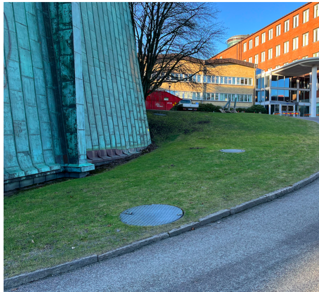
Figur 3: Brunnar med filter runt Kopparbunken. Foto: Evelina Skantz
