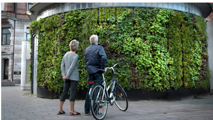
Figur 10: Pumphuset på Sundstorget, Helsingborg. Foto: Eva Lie (Helsingborgs stad, 2020).
